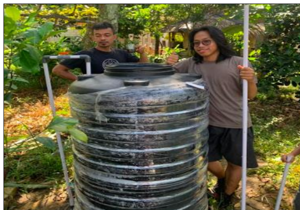
Gambar 10. Pemasangan Toren di Lokasi Akhir
