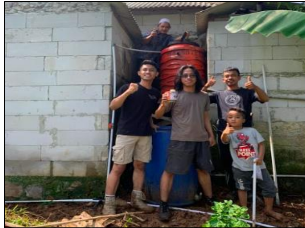
Gambar 11. Pemasangan Slauran Air ke Musholla
