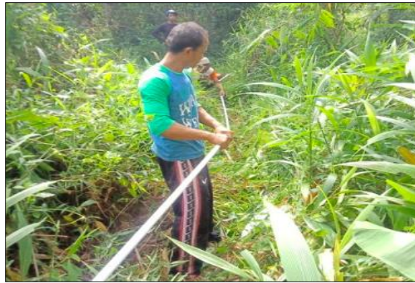
Gambar 8. Proses Pemasangan Pipa
