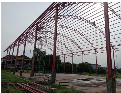
Gambar 1. Proses Pembangunan Gedung Olahraga
