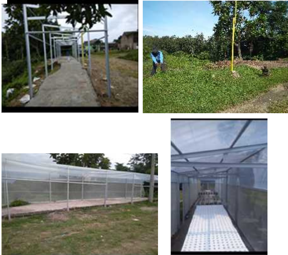
Gambar 2 : Pekerjaan Pemasangan Infrastruktur Hidroponik
