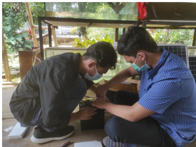
Gambar 7. Pemasangan baterai sebagai media penyimpanan energi listrik
