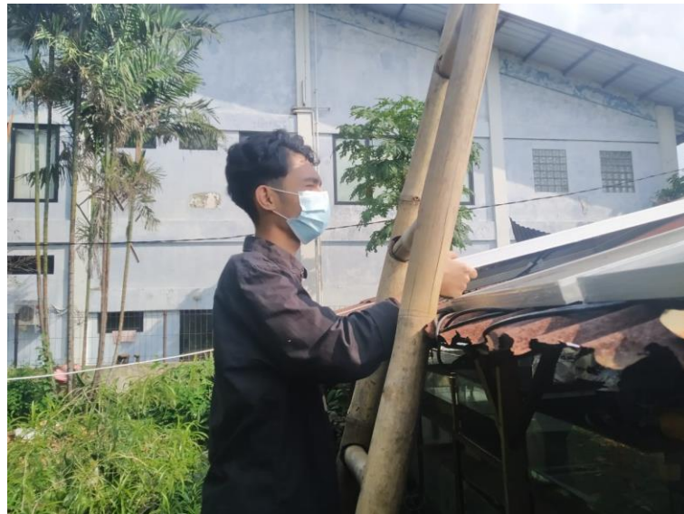
Gambar 6. Pemasangan panel surya di lokasi mitra
