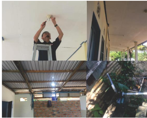
Gambar 5. Proses Instalasi dan uji coba
