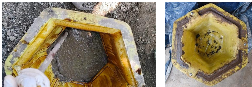
Gambar 2. Proses cetak pot geopolimer
