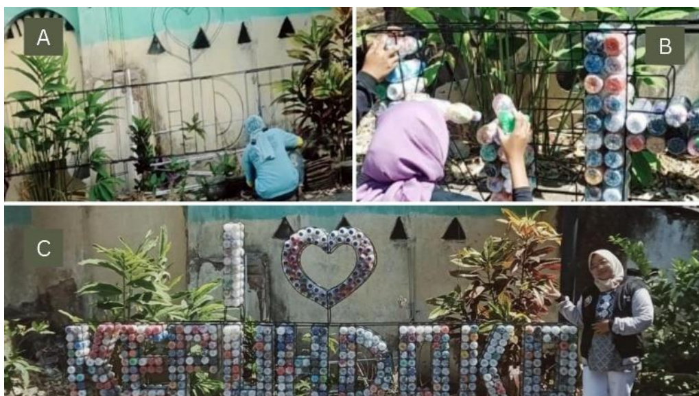
Gambar 3. Konstruksi eco bricks (A), penataan eco bricks pada kawat konstruksi (B), hasil akhir (C) Sumber: dokumentasi tim pelaksana, 2023
