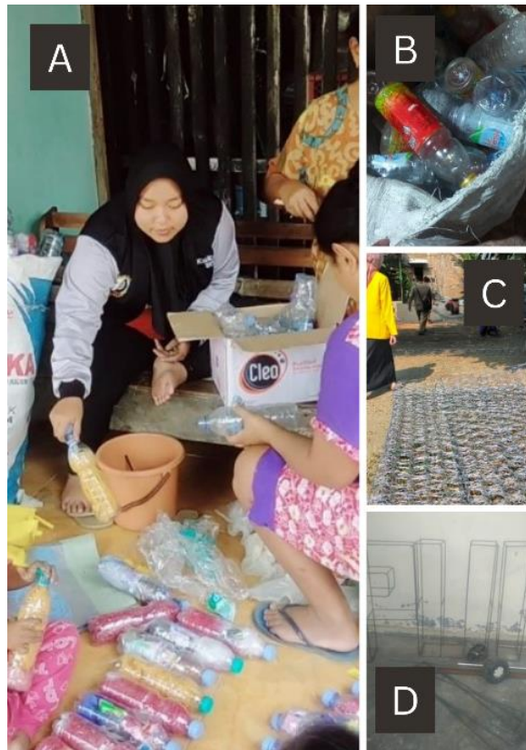
Gambar 1. Pemanfaatan limbah botol dan plastik bekas untuk eco bricks dan kawat/besi konstruksinya
