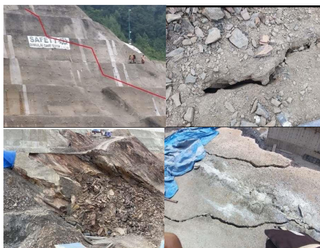
Gambar 1. Tanda Pergerakan Tanah berupa Debris Slide pada Tebing Tumpuan Kiri
